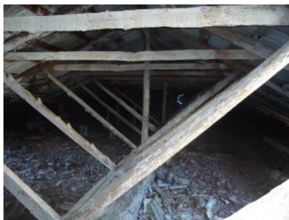
Նկ. 8 Տանիքի կոնստրուկտիվ տարրերի թերությունների օվնսվածքների տեսքեր
