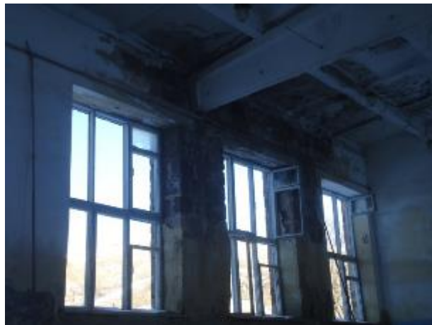
Նկ. 4 Մթնոլորտային տեղումների ջրերի ազդեցությունից առաջացած վնասվածքների տեսքեր
