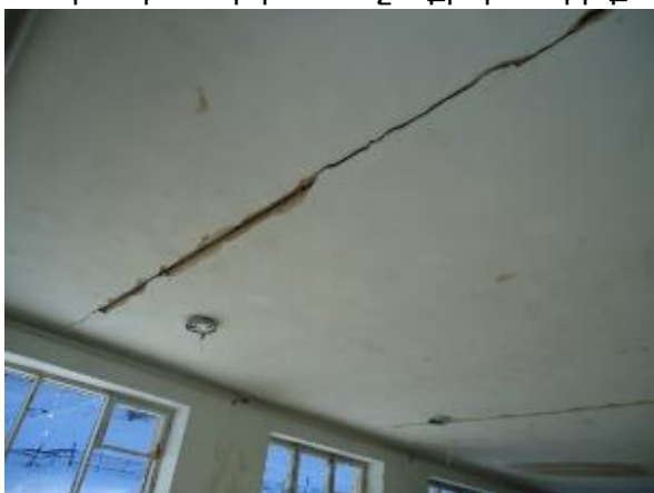
Նկ.3 Միջհարկային ծածկերի օվերնաձածկի հավաքովի/բաւերի վնասվածքի տեսքեր
