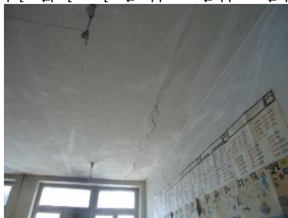
Նկ.3 Միջհարկային ծածկերի օվերնաձածկի հավաքովի/բաւերի վնասվածքի տեսքեր
