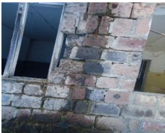
Նկ. 2 Միահարկ մասնաշենքի պատերի քարաշարվածքի վնասվածքների և ճաքերի տեսքեր
