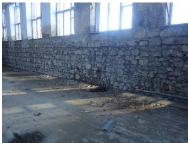
Նկ. 2 Միահարկ մասնաշենքի պատերի քարաշարվածքի վնասվածքների և ճաքերի տեսքեր
