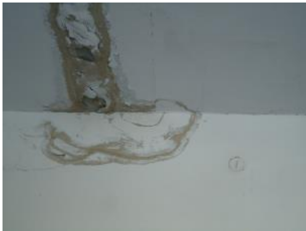
Նկ. 4 Մթնոլորտային տեղումների ջրերի ազդեցությունից առաջացած վնասվածքների տեսքեր
