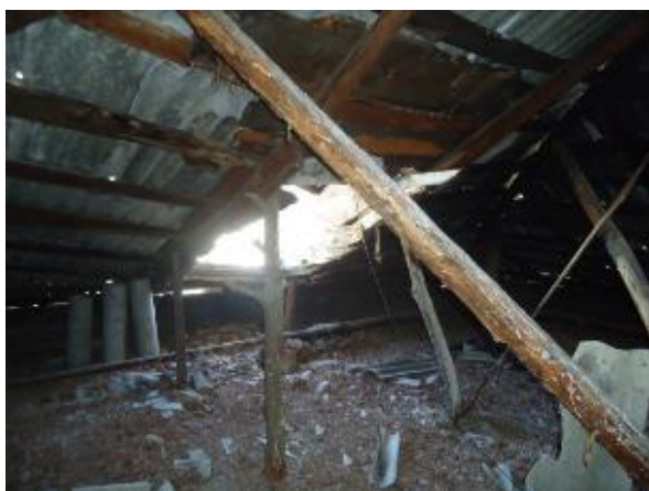
Նկ. 8 Տանիքի կոնստրուկտիվ տարրերի թերությունների օվնսվածքների տեսքեր
