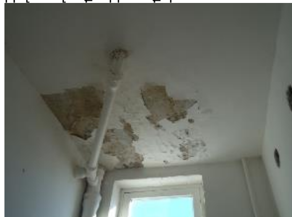
Նկ. 5 Տանիքից ներթափանցած մթնոլորտային տեղումների ջրերի ազդեցությունից առաջացած վնասվածքների տեսքեր
