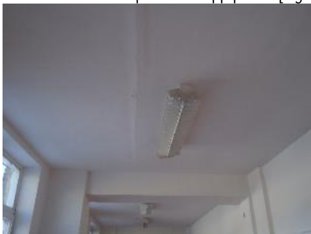
Նկ.3 Ծածկերի հավաքովի/բսալերի միմյանց նկատմամբ տեղաշարժերի տեսքեր
