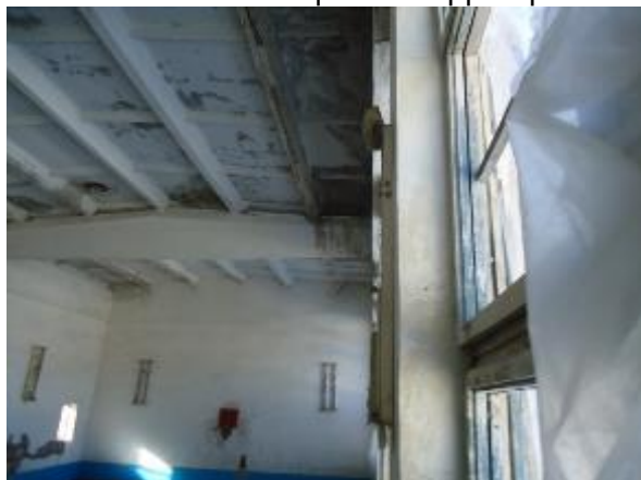
Նկ. 5 Տանիքից ներթափանցած մթնոլորտային տեղումների ջրերի ազդեցությունից առաջացած վնասվածքների տեսքեր
