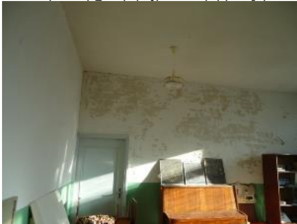
Նկ. 3 Միջհարկային ծածկերի ու վերնածածկի հավաքովի/բալերի վնասվածքի տեսքեր
