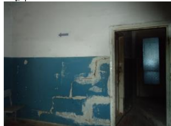
Նկ. 5 Միջնորմերի վնասվածքների հնարքերի տեսքեր
