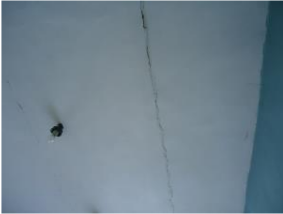
Նկ. 3 Միջհարկային ծածկերի ու վերնածածկի հավաքովի/բալերի վնասվածքի տեսքեր
