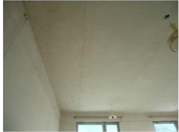
Նկ. 3 Միջհարկային ծածկերի ու վերնածածկի հավաքովի/բալերի վնասվածքի տեսքեր
