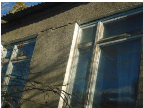
Նկ. 2 Պատերի քարաշարվածքի վնասվածքների և ճաքերի տեսքեր
