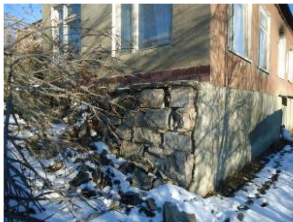
Նկ. 2 Պատերի քարաշարվածքի վնասվածքների և ճաքերի տեսքեր
