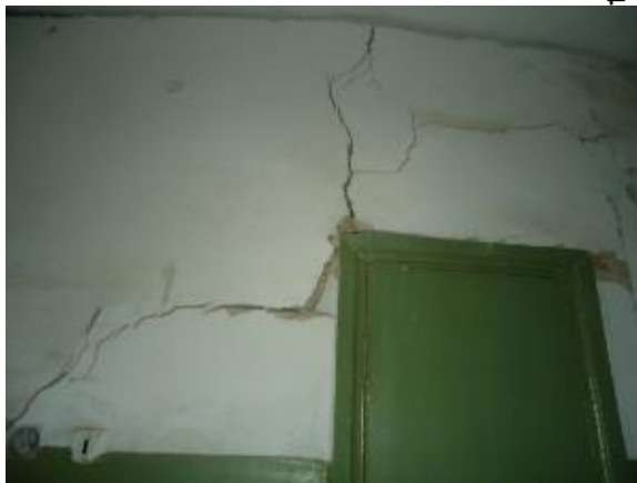
Նկ. 5 Միջնորմերի վնասվածքների հնարքերի տեսքեր
