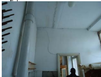
Տանիքից ներթափանցած մթնոլորտային տեղումների ջրերի ազդեցությունից առաջացած վնասվածքների տեսքեր
