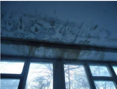
Տանիքից ներթափանցած մթնոլորտային տեղումների ջրերի ազդեցությունից առաջացած վնասվածքների տեսքեր
