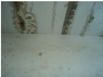
Միջհարկային ծածկերի փլուզումներն առաջնահերթ հավաքողի և/կամ սալերի վնասվածքի տեսքեր
