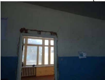
Տանիքից ներթափանցած մթնոլորտային տեղումների ջրերի ազդեցությունից առաջացած վնասվածքների տեսքեր
