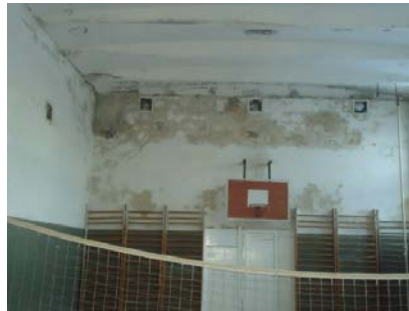
Տանիքից ներթափանցած մթնոլորտային տեղումների ջրերի ազդեցությունից առաջացած վնասվածքների տեսքեր
