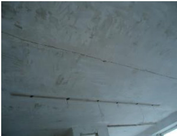
Նկ. 5 Ծածկերի հավաքովի ե/բ սալերի միմյանց նկատմամբ տեղաշարժերի տեսքեր
