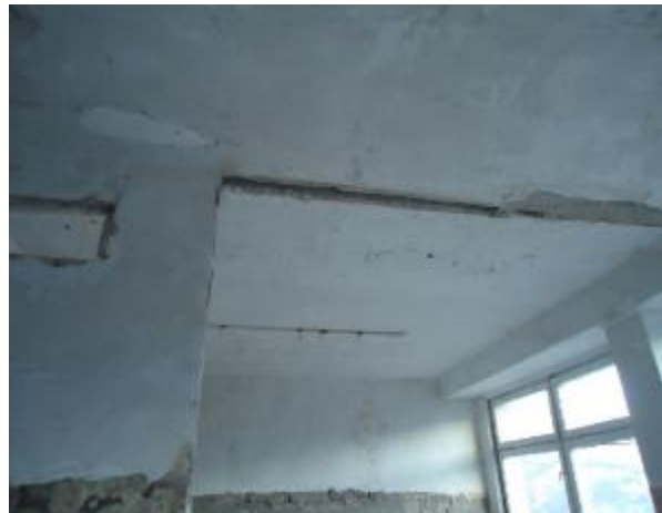
Նկ. 5 Ծածկերի հավաքովի ե/բ սալերի միմյանց նկատմամբ տեղաշարժերի տեսքեր
