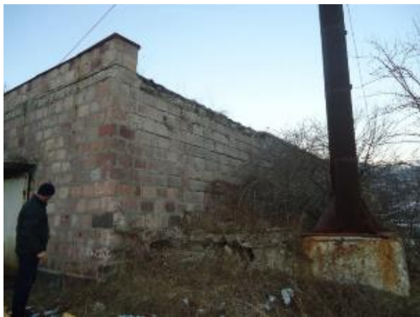
Նկ. 9 Կաթսայատան կոնստրուկտիվ տարրերի վնասվածքների տեսքեր
