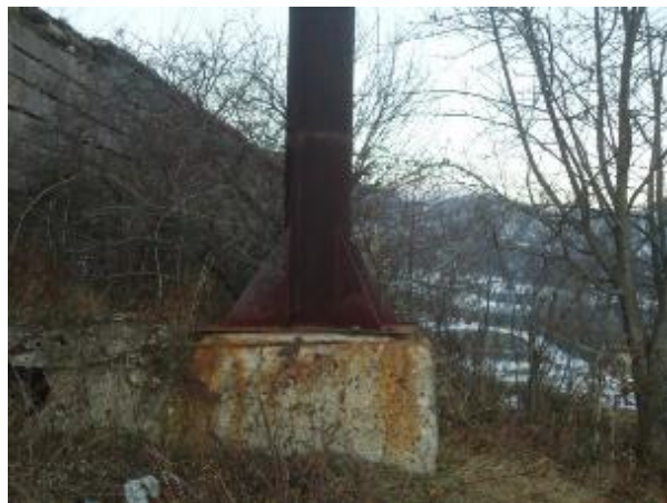
Նկ. 9 Կաթսայատան կոնստրուկտիվ տարրերի վնասվածքների տեսքեր
