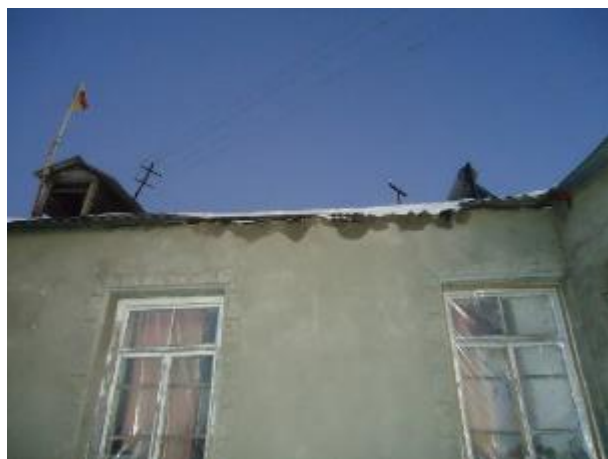
Նկ. 2 Տանիքի կոնստրուկտիվ տարրերի վնասվածքների տեսքեր
