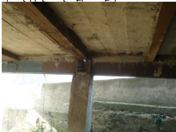
Նկ. 3 Կցակառույցների նկուղային հարկի միաձուլվե/բկոնստրուկցիաների վնասվածքների տեսքեր
