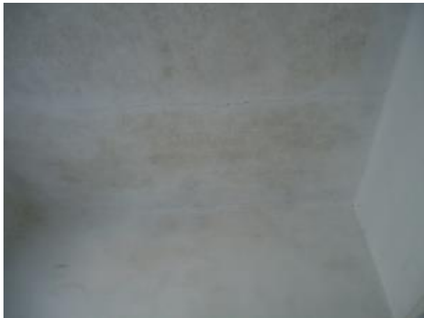
Նկ. 2 Վերնաձածկի հավաքովի/բալեթի վնասվածքի տեսքեր
