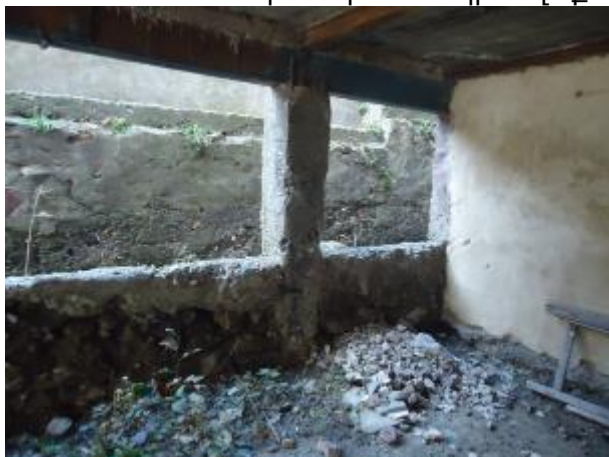
Նկ. 3 Կցակառույցների նկուղային հարկի միաձուլվե/բկոնստրուկցիաների վնասվածքների տեսքեր
