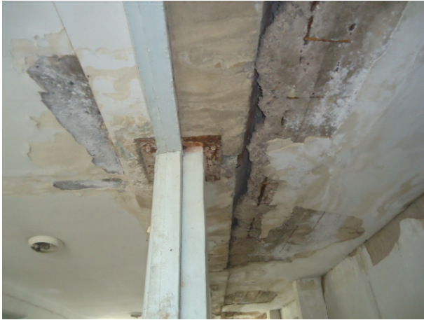
Նկ. 5 Ե/բայանևհեծաններինմիացմանհանգույցներիփաստացիտեսքեր
