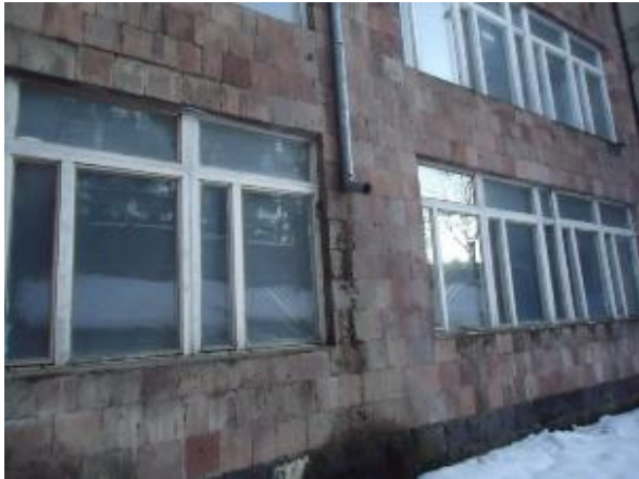
Նկ. 2 Պատերի քարաշարվածքի վնասվածքների և ճաքերի տեսքեր
