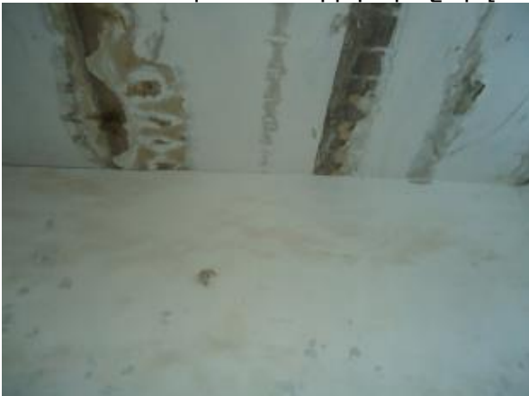
Նկ. 2 Պատերի քարաշարվածքի վնասվածքների և ճաքերի տեսքեր
