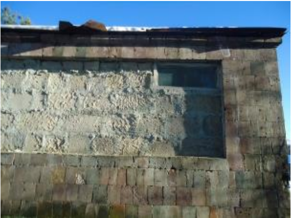
Նկ. 2 Պատերի քարաշարվածքի վնասվածքների և ճաքերի տեսքեր
