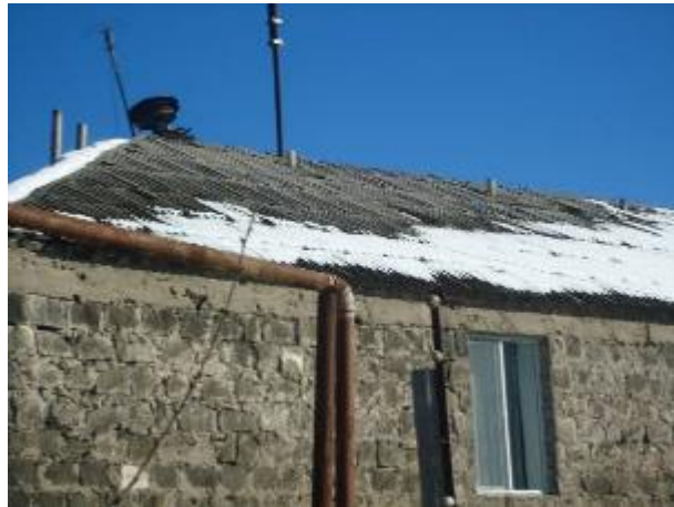
Նկ. 2 Տանիքի կոնստրուկտիվ տարրերի վնասվածքների տեսքեր
