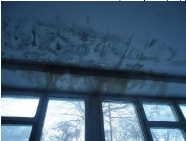
8 Տանիքից ներթափանցած մթնոլորտային տեղումների ջրերի ազդեցությունից առաջացած վնասվածքների տեսքեր
