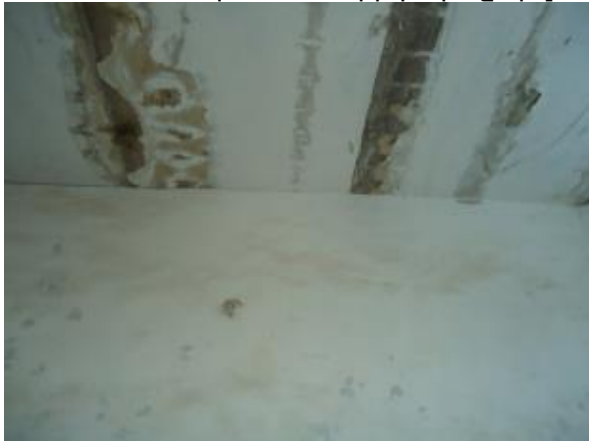
Նկ. 4 Միջհարկային ծածկերի ու վերնածածկի հավաքովի/բալկոնի վնասվածքի տեսքեր
