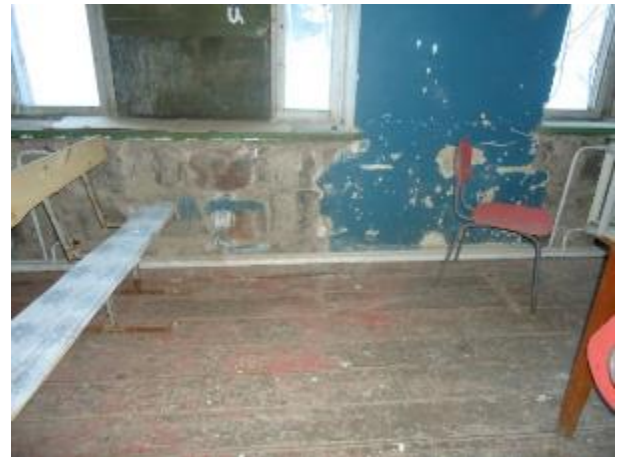
8 Տանիքից ներթափանցած մթնոլորտային տեղումների ջրերի ազդեցությունից առաջացած վնասվածքների տեսքեր
