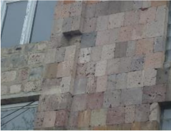
Նկ. 3 Պատերի քարաշարվածքի վնասվածքների և ճաքերի տեսքեր
