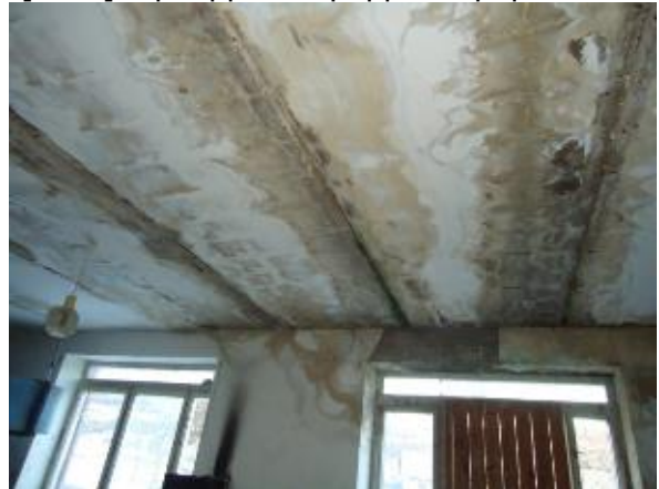
Նկ. 4 Միջհարկային ծածկերի ու վերնածածկի հավաքովի/բալկոնի վնասվածքի տեսքեր
