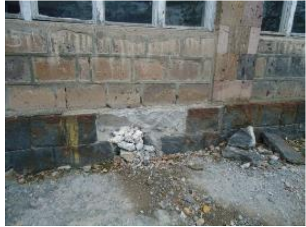
Նկ. 3 Պատերի քարաշարվածքի վնասվածքների և ճաքերի տեսքեր
