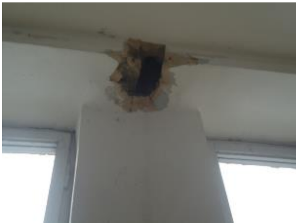
Նկ. 2 Հավաքովի/բիեծանների ուսյունների միացման հանգույցների տեսքեր
