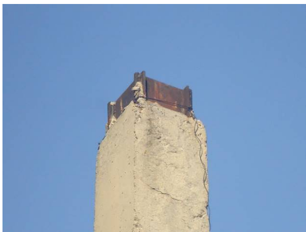
Նկ. 5ИИС-04 սերիայի հավաքովի երկաթբետոնյա սյուների վնասվածքներ
