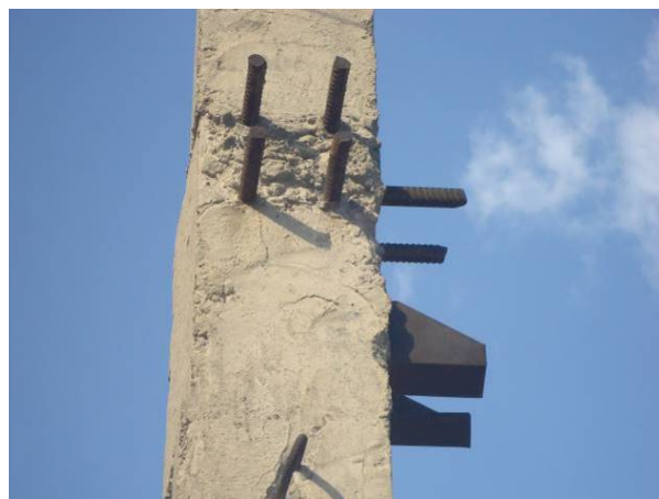
Նկ. 5ИИС-04 սերիայի հավաքովի երկաթբետոնյա սյուների վնասվածքներ
